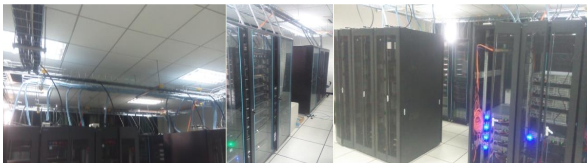
图 5-2 服务器室综合布线与环境改造工程
